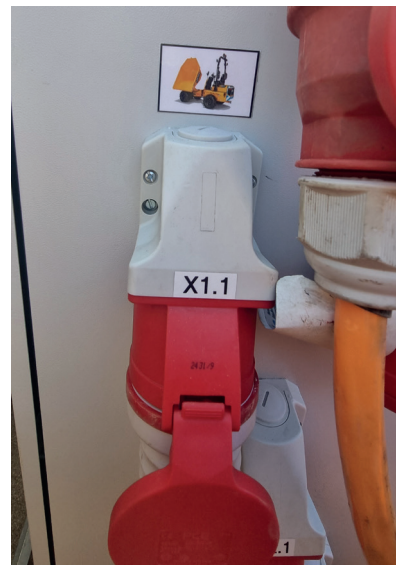
Abbildung 6: Beschriftung und Beschilderung der Steckdosen für die Verbraucher
