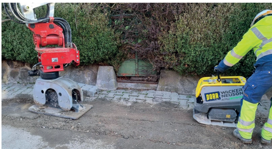
Abbildung 11: Zusätzliche Verdichtung mit Anbauwerkzeug für den Bagger aufgrund des zu geringen Gewichts der handgeführten Verdichtungsgeräte
