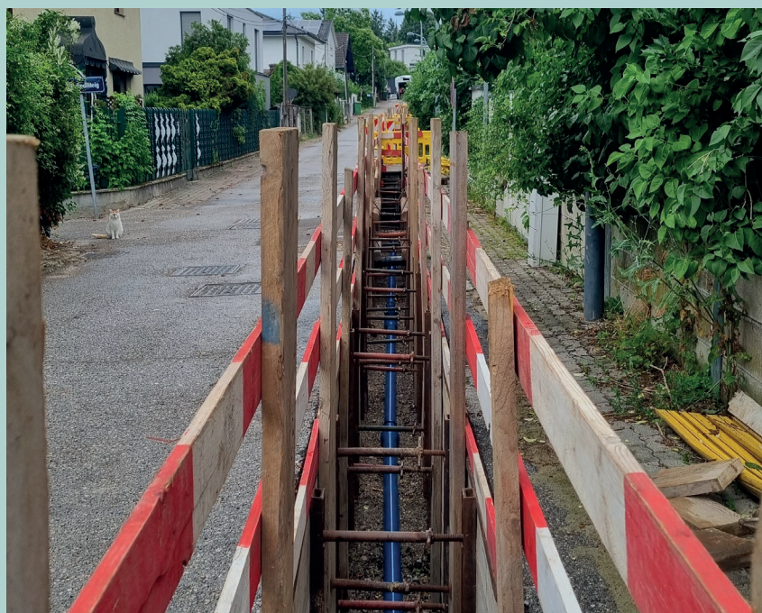
Abbildung 3: Baustelle Alpengartenstraße – Ansicht der ausgehobenen und gesicherten Künette mit erneuertem Wasserrohr
